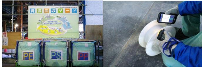
(左)資源回収ヤード、(右)廃プラスチックの材質確認
